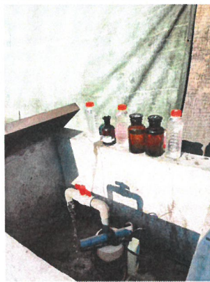
地下水检测井 (2)
